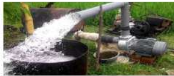
Gambar 2. 1 Sumur Bor (Sumber: rachmat, 2021)
